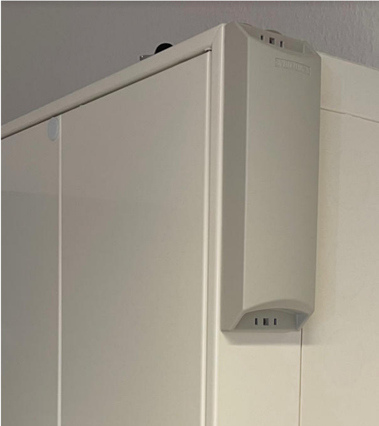
Abbildung 1: Seitlich montierte Antenne mit Hilfe der Klebepads.
